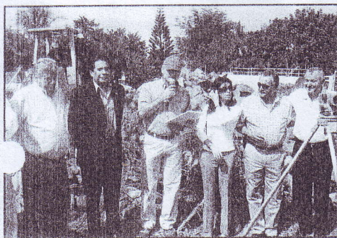
Inicio de obras con la presencia de autoridades municipales.
